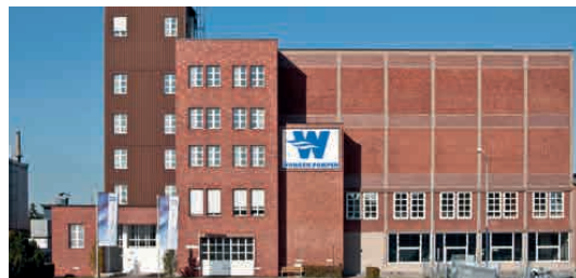
Hauptgebäude in Wangen
