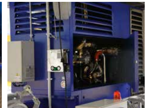
lärmgekapstelter Motor
