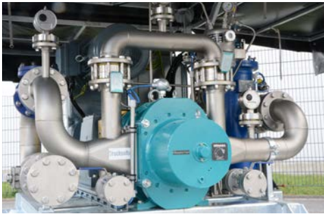
Drehkolbenpumpe und Variodeckel in ATEX-konformer Bauweise
