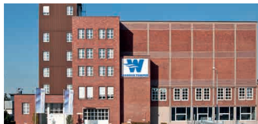
Hauptgebäude in Wangen
