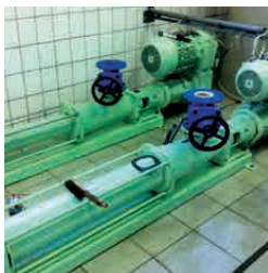
Convoyage des boues fines : Pompe à vis excentrique KL50S
