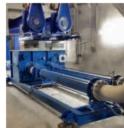
Convoyage de boues d'épuration asséchées : KL80RQ110.4+110.4 Pompe à vis excentrique
